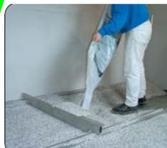
**Remblayer et régler:** Remblayer section par section. Placer une règle de nivellement à la hauteur de référence et planifier Thermo Plan de manière circulaire. La profondeur de pénétration peut être contrôlée par une inclinaison de la règle.
