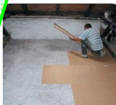
**Couvrir:** Couvrir Plan par un carton ondulé afin de protéger la Perlite et de retenir le ciment.
