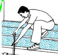
**2ème étape:** à l'aide d'une règle, tirer à niveau le matériau, grâce au bord supérieur des solives sans laisser de creux.
