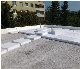
**Bau-europerl<sup>®</sup> Typ W4** ummantelt, wasserabweisend, kraftschlüssig & tragfähig
