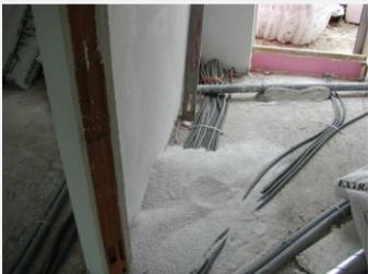
**Einsatzgebiet** : tragende Schüttung unter schwimmenden Nassestrich, sowie Hohlraumdämmung (wie **Thermo-Fill<sup>®</sup>**)
