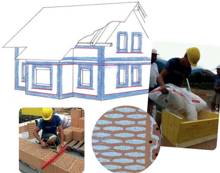
Durch Verfüllen der Ziegelschar unter und ober jeder Decke / Zwischendecke, der Ziegel an den Ecken und rund um Fenster und Türen, können Kältebrücken verhindert und die Wärmdämmeigenschaften der Mauer stark verbessert werden.
