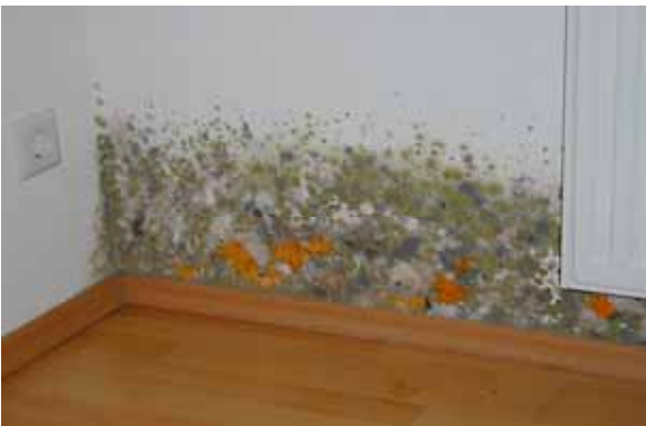
Quelle: IBO massiver Schimmelbefall
