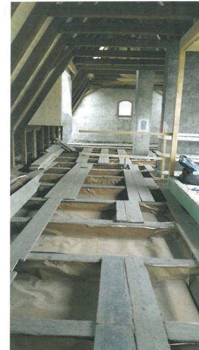
VORBEREITUNG DER BAUSTELLE. Einbringen von Thermo-Baupapier als Windbruch und Rieselschutz
