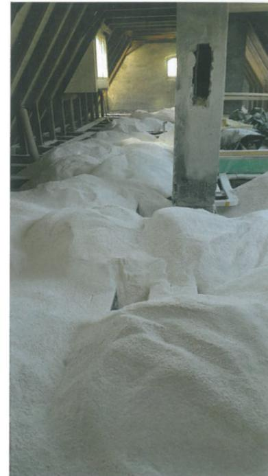
EINFACH. Nach dem Einblasen der Dämmschüttung. Jetzt nur noch mit einer Latte verteilen – und fertig.
