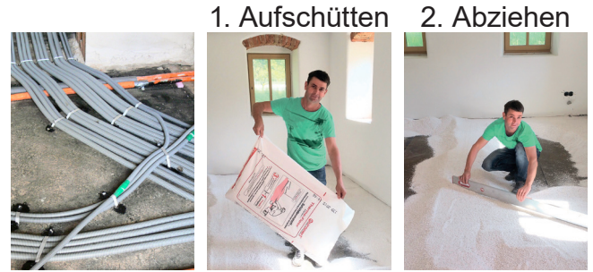
3. Verdichten → fertig!
