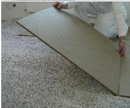
Auf Trockenheit prüfen (s. Hinweise Anwendung), gegebenenfalls ablüften/ trocknen. Dämmschüttung mit **Thermo-A8+ (Abdeckplatten)** unter Vermeidung von Kreuzfugen abdecken. Berücksichtigen Sie, dass Holzweichfaserplatten leicht Feuchtigkeit aufnehmen – hier jedoch unbedingt trocken eingebaut werden müssen. Sicherheit bietet hier unsere **Thermo-A8+**. Hierauf folgt die Verlegung des Trockenestriches.
