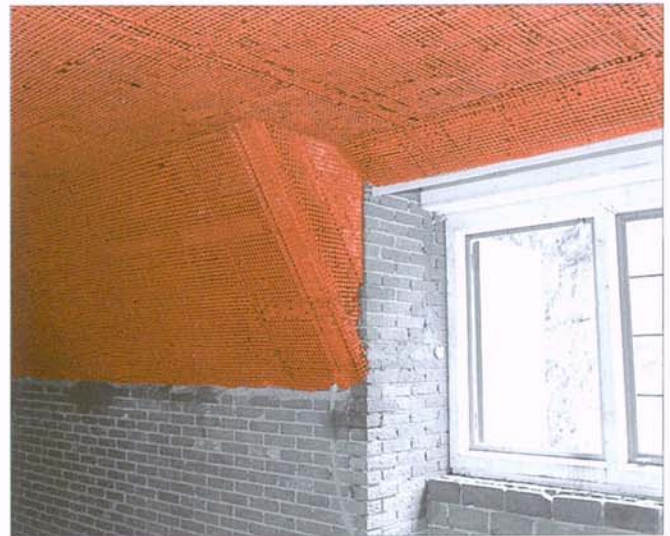
Die unterseitige Bekleidung von Dachschräge und Dachdecke mit Stauss-Ziegeldraht verbessert in Verbindung mit entsprechenden Putzmörteln das Brandverhalten der Gesamtkonstruktion.
