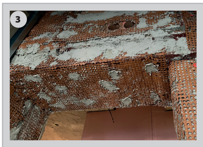
3 Kompletně připravené kovové prvky a nerovné zdi pro omítnutí.
