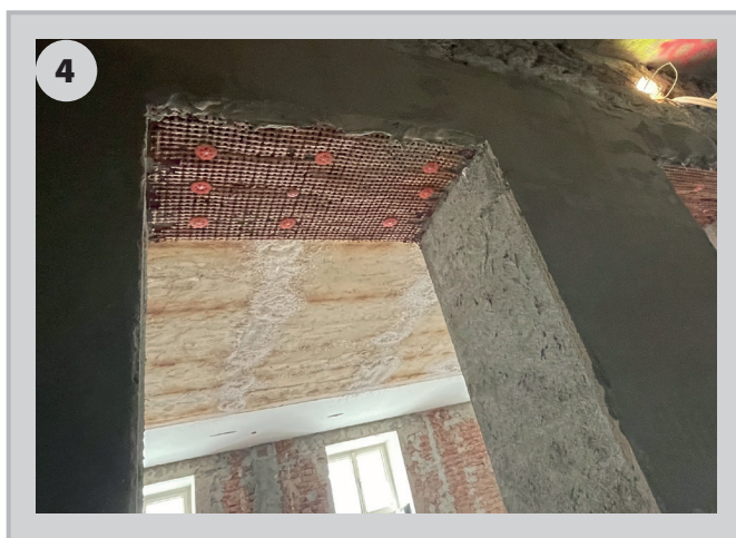
4 Omítnutí kovových výztuh nosných stěn.
