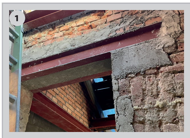
1 Holé nosníky, výztuhy nosných stěn z kovu a překlady pro zahození a omítnutí.
