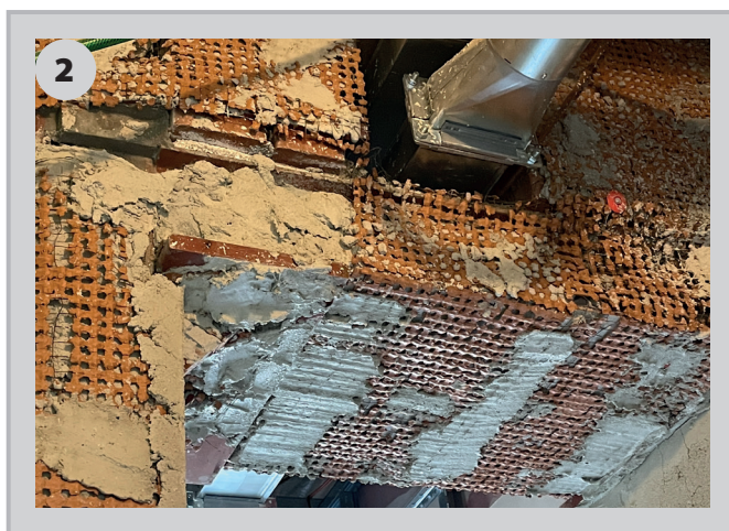
2 Částečné vylití profilů H a obalení kovových nosníků pro omítnutí.
